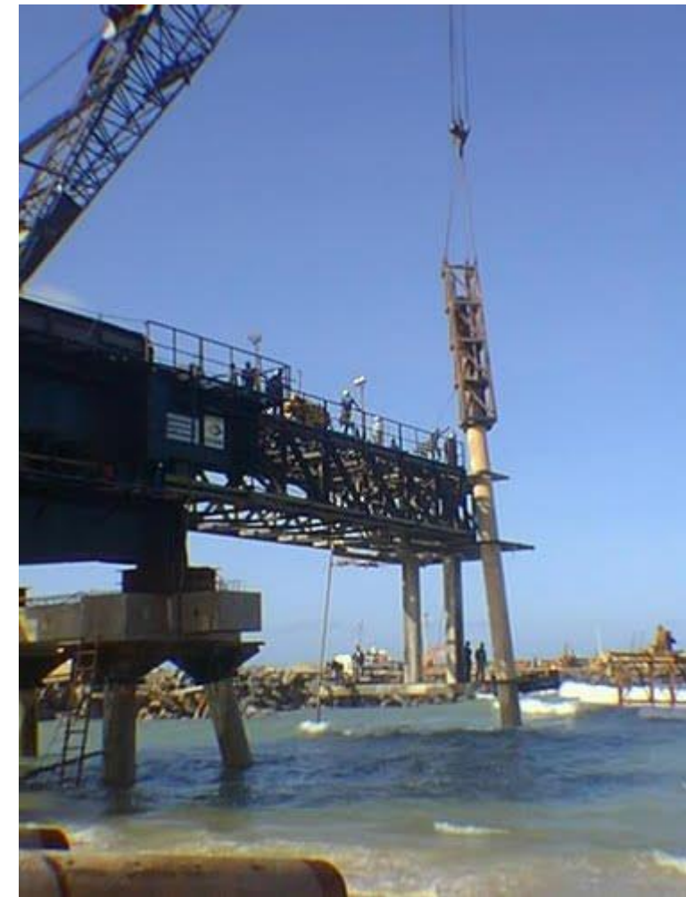
Figura 20 – Contitraveller cravando estacas.
