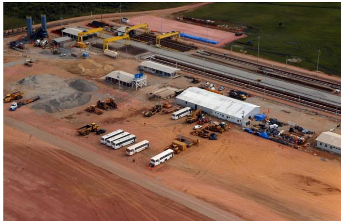
Figura 31 - Canteiro de pré-moldados.
