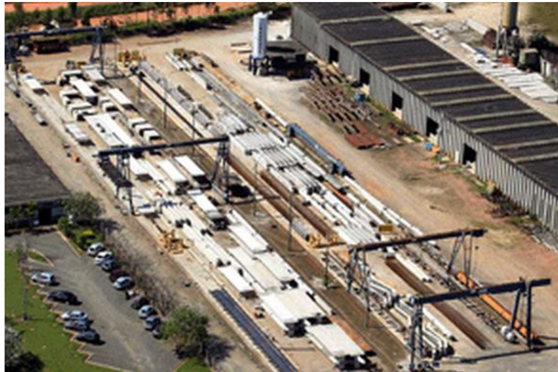
Figura 30 – Canteiro de pré-moldados.
