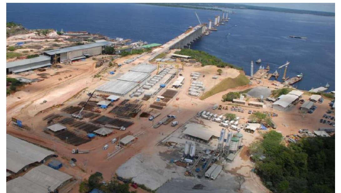
Figura 33 - Canteiro de pré-moldados.
