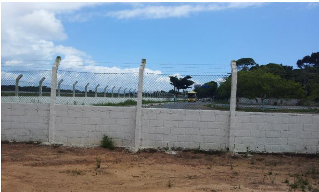
Figura 1-14: Rua de acesso ao aeroporto e muro - Obstáculos
