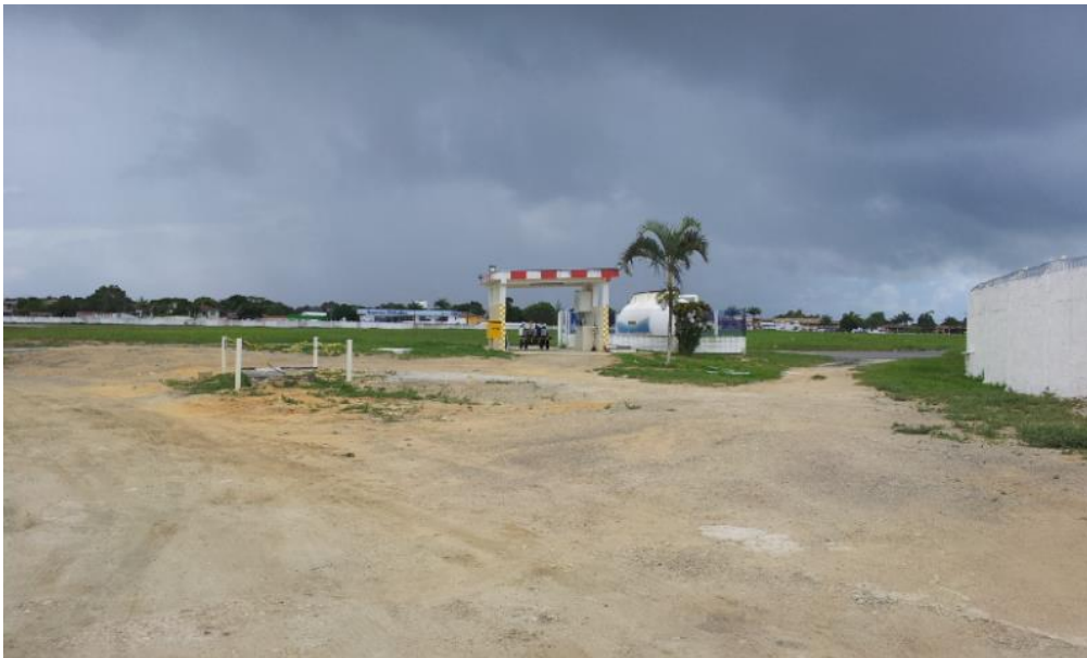
Figura 1-11: ETE - Estação de tratamento de esgotos - Obstáculo
